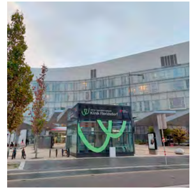
Auch die Klinik Floridsdorf befindet sich hier. Foto: Antonio Sečerović/RMW
