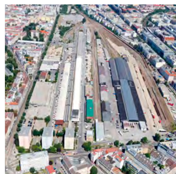
Derzeit werden alle Gebäude und Gleise entfernt.
