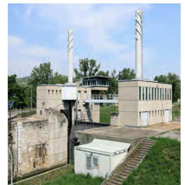
Die Wehr- und Schleusenanlage befindet sich am Sporn.
