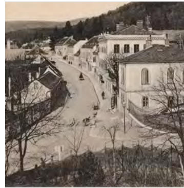
Ein Blick auf die Neuwaldegger Straße um 1905.
