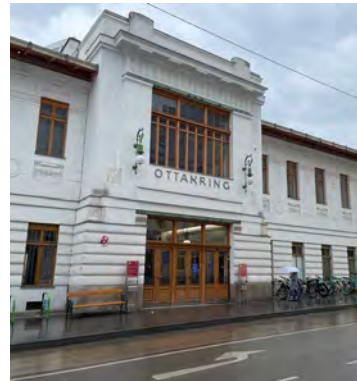
Das Stationsgebäude Ottakring hat Otto Wagner entworfen. Fotos (2): mjp
