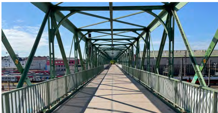
Der Rustensteg verbindet mit rund 208 Metern Länge die beiden Bezirksteile Rudolfsheim und Fünfhaus mit Neu-Fünfhaus.
